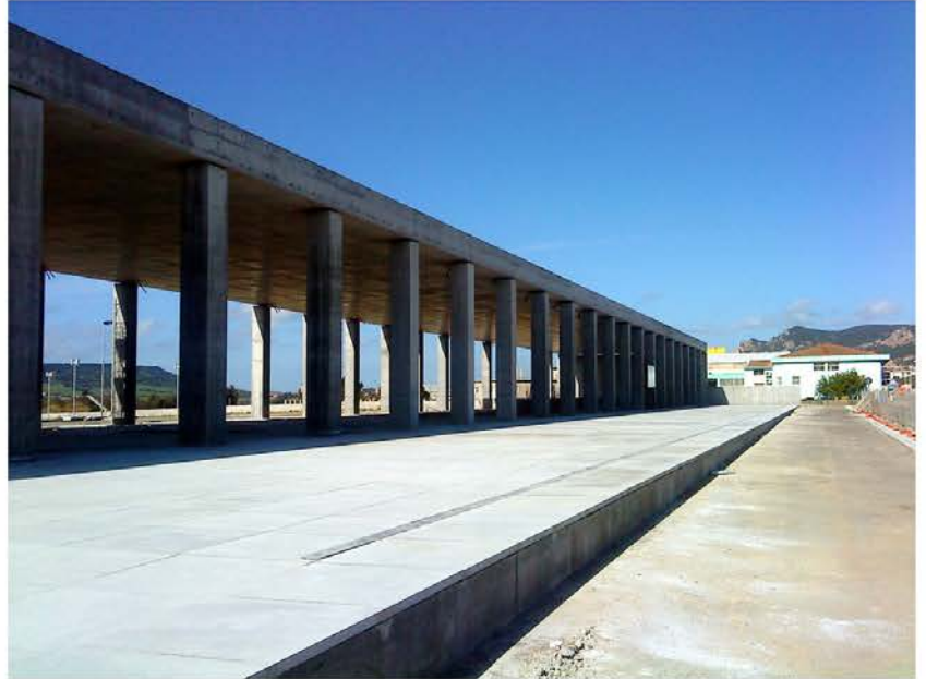
[8] IL PROSPETTO PRINCIPALE DEL CENTRO INTERMODALE SULLA NUOVA PIAZZA (FOTO DI STEFANO OLIVIERO).
