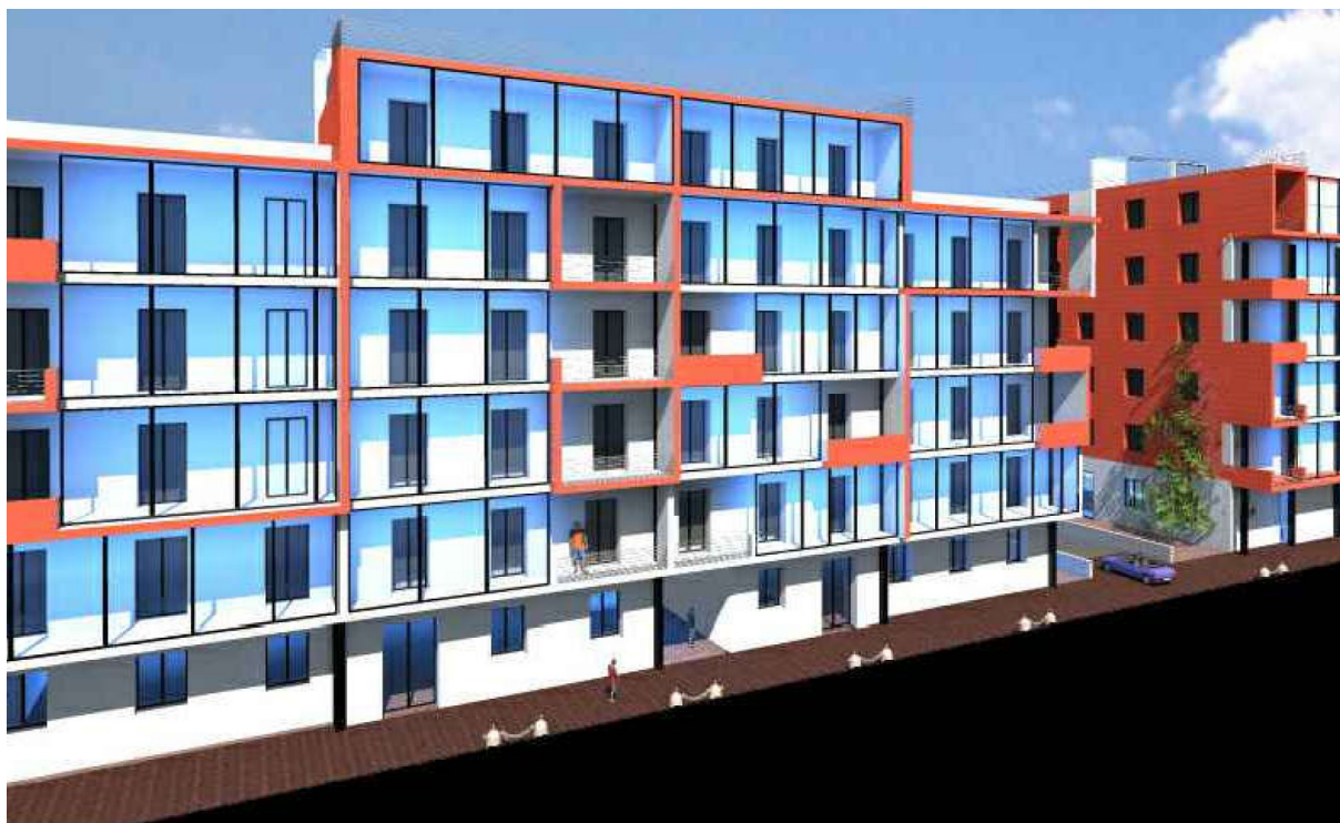
Fig. 4 - Esempio progettuale di un intervento “additivo” in cui, ad un edificio esistente, viene aggiunta una nuova pelle in grado di aumentare le prestazioni dell’involucro, di creare nuovi spazi di mediazione tra interno ed esterno ed ospitare dispositivi impiantistici efficienti ed alimentati da energie rinnovabili (fonte: E. Umamo, Potenzialità e criticità nella riqualificazione sostenibile dell’edilizia popolare. Un nuovo volto per un complesso di edifici del dopoguerra . Tesi di Laurea in Architettura delle Costruzioni. A.A. 2011-12).
