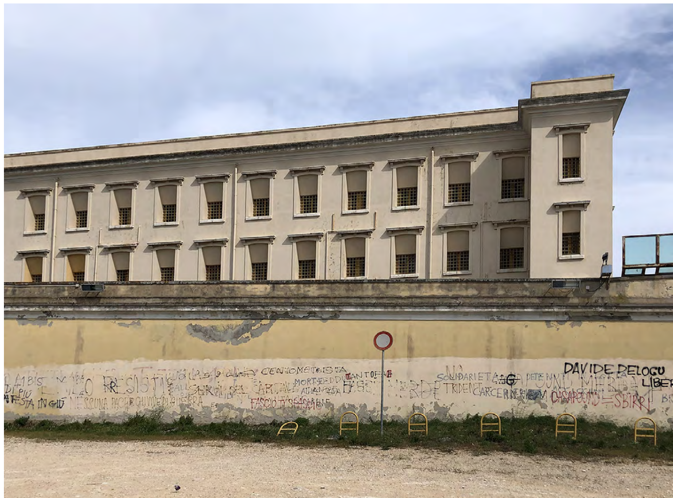
Figura 1. Un braccio interno del Carcere dopo l'abbandono (foto autore anno).
