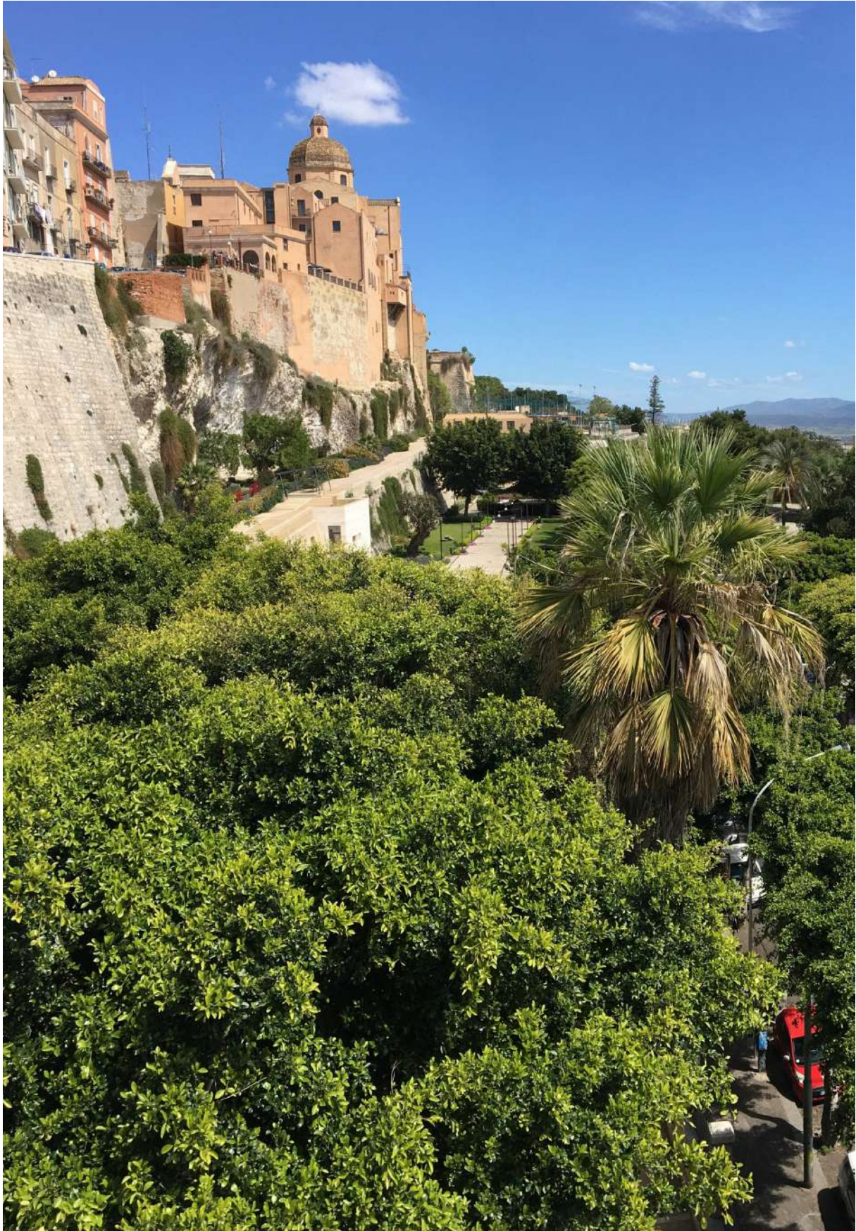
Figura 7- Giardini sotto le mura e Viale Regina Elena, Cagliari. Foto dell'autore.
