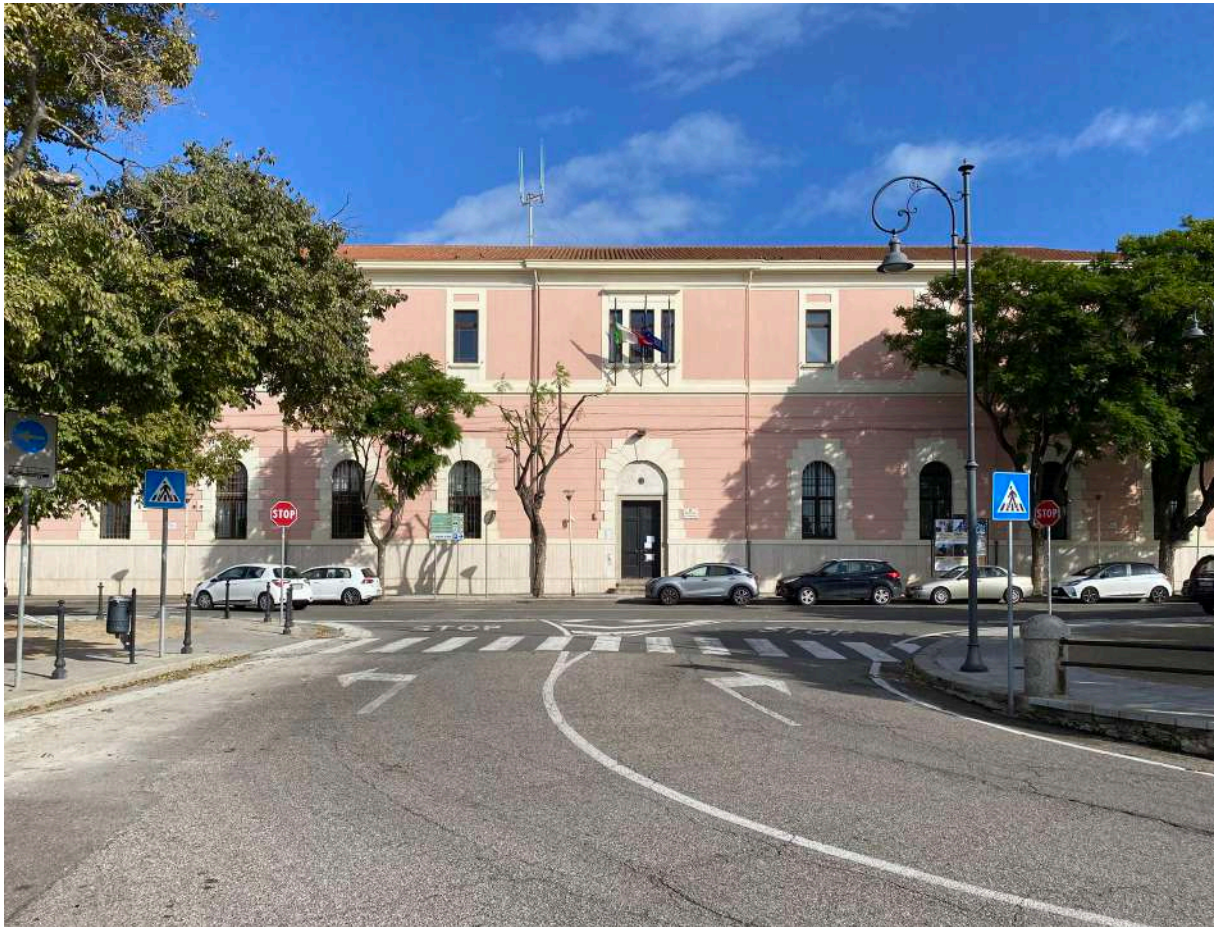
Figura 8 - Ex Tribunale Militare di Cagliari (Caserma Fadda), Viale Buon Cammino, Cagliari CA, oggi sede della Prefettura. Patrimonio Indisponibile, in uso a Pubblica Amministrazione. Fonte: (OpenDemanio – Geolocalizzazione. Fabbricati dello Stato). Foto dell'autore, 2022.
