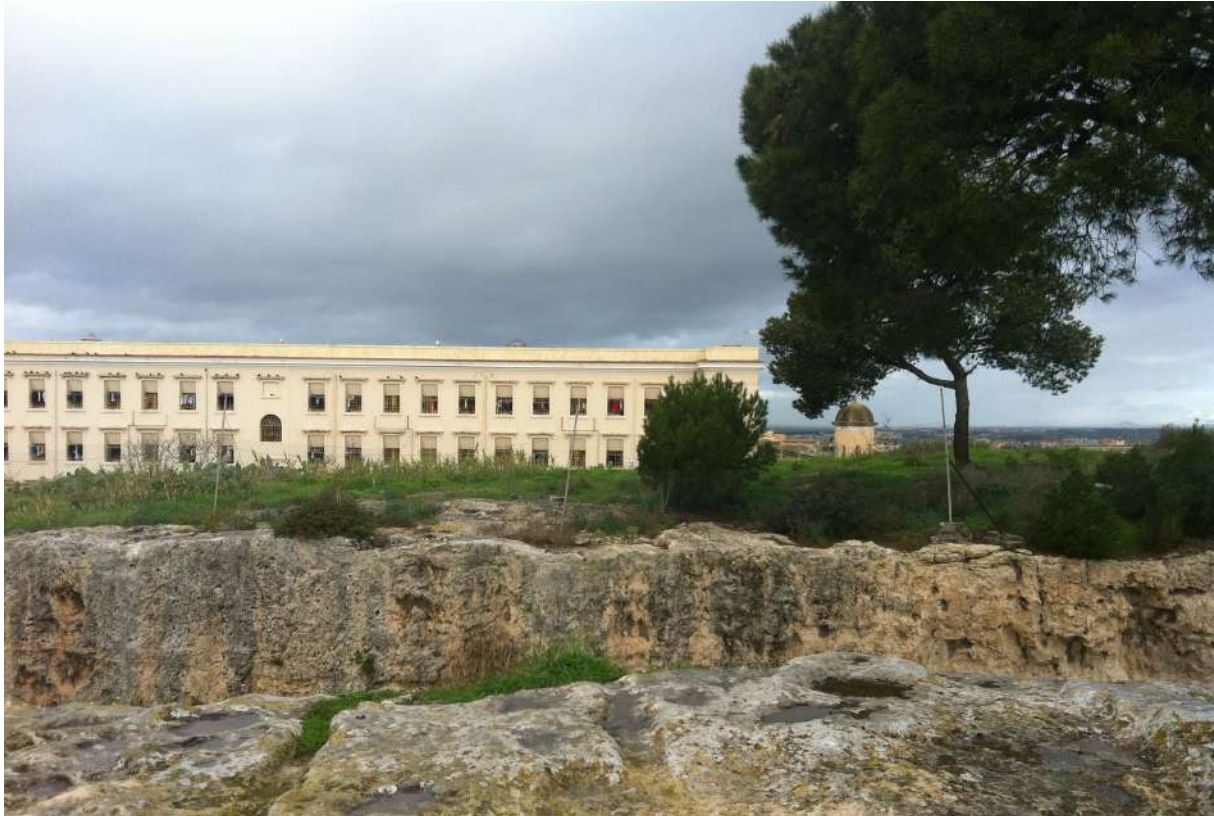
Figura 3a - Ex carcere di Buoncammino. Viale Buoncammino, Cagliari. Demanio Storico Artistico, in parte in uso alla Pubblica Amministrazione Centrale, a seguito del trasferimento dei detenuti. Fonte: (OpenDemanio – Geolocalizzazione. Fabbricati dello Stato) . Foto dell'autore, 2022.
