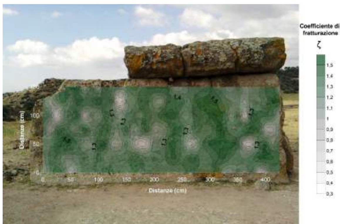
Fig. 4. MORES – Dolmen di Sa Coveccada. Paramento sud – mappa della distribuzione dei valori del coefficiente di fratturazione ( \zeta ).
