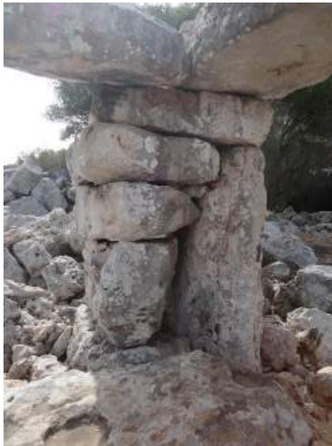
Fig. 4. ALAIOR - Na Comerma de Sa Garita. Contrafuerte fachada sur.
